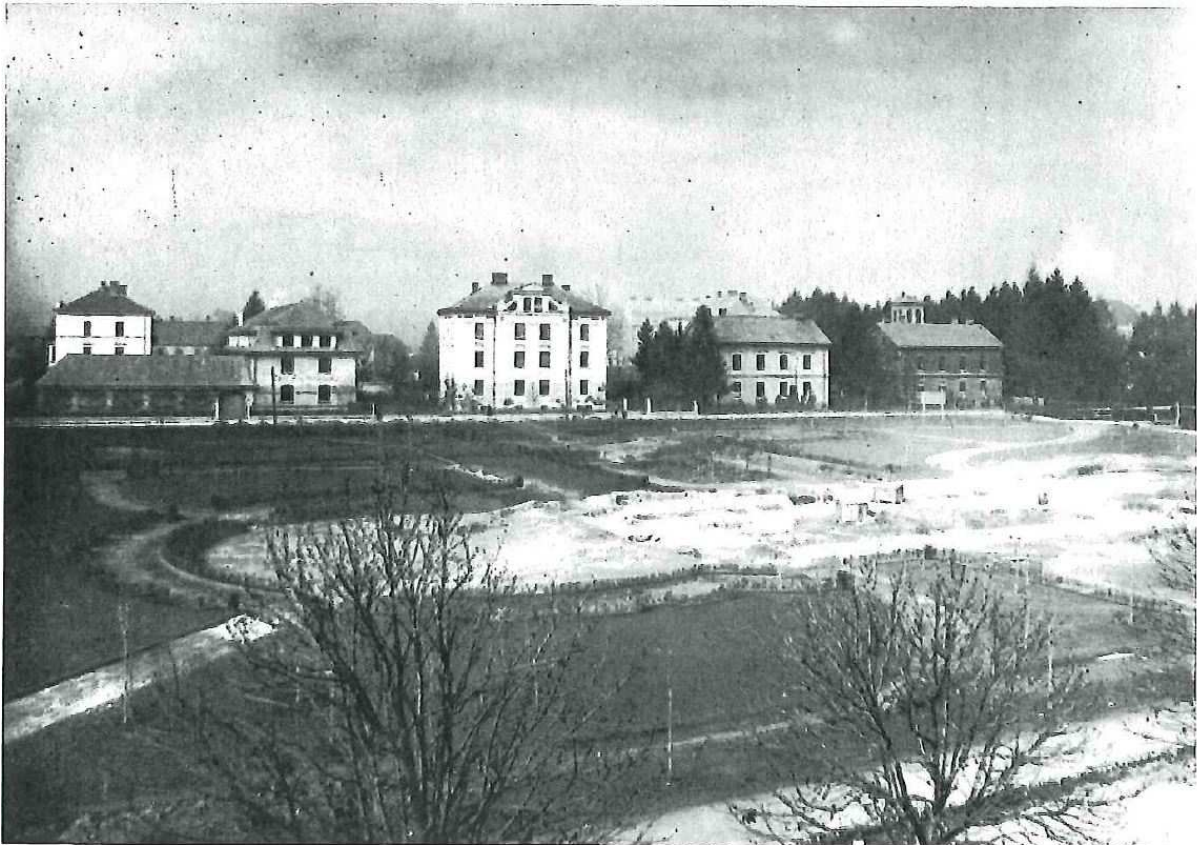
Abb. 5: Beginn der Arbeiten am Stadtpark 1927.
