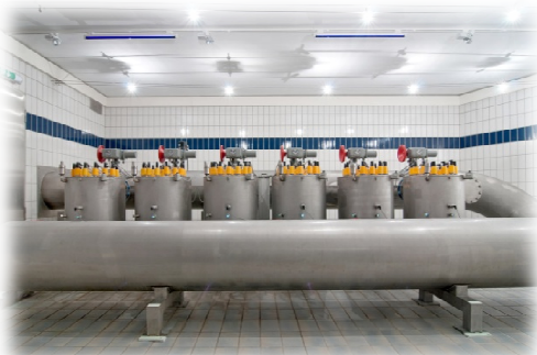
UV-Desinfektionsanlage Obere Fellach
