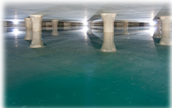
Wasserkammer Hochbehälter Kumitzberg
