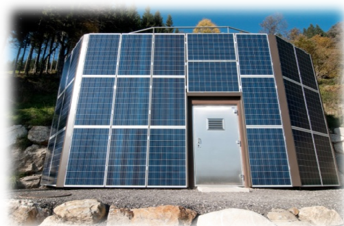
Photovoltaikanlage Hochbehälter Oberwollanig
