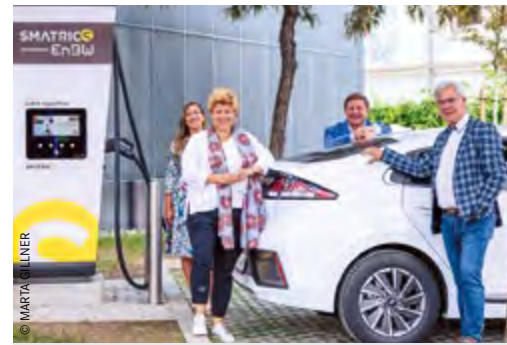
Die neue Schnellladestation lässt E-Autos mit bis zu 300kW aufladen.
