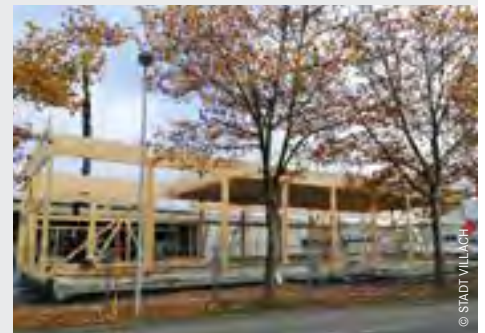
Blick auf die aktuellen Arbeiten am EMV-Labor im Technologiepark.
