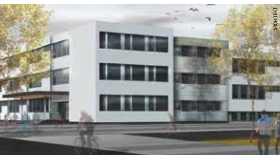
Eine Grafik des rundum erneuerten Gebäudes in der Trattengasse, das Ende Februar feierlich eröffnet wird.
