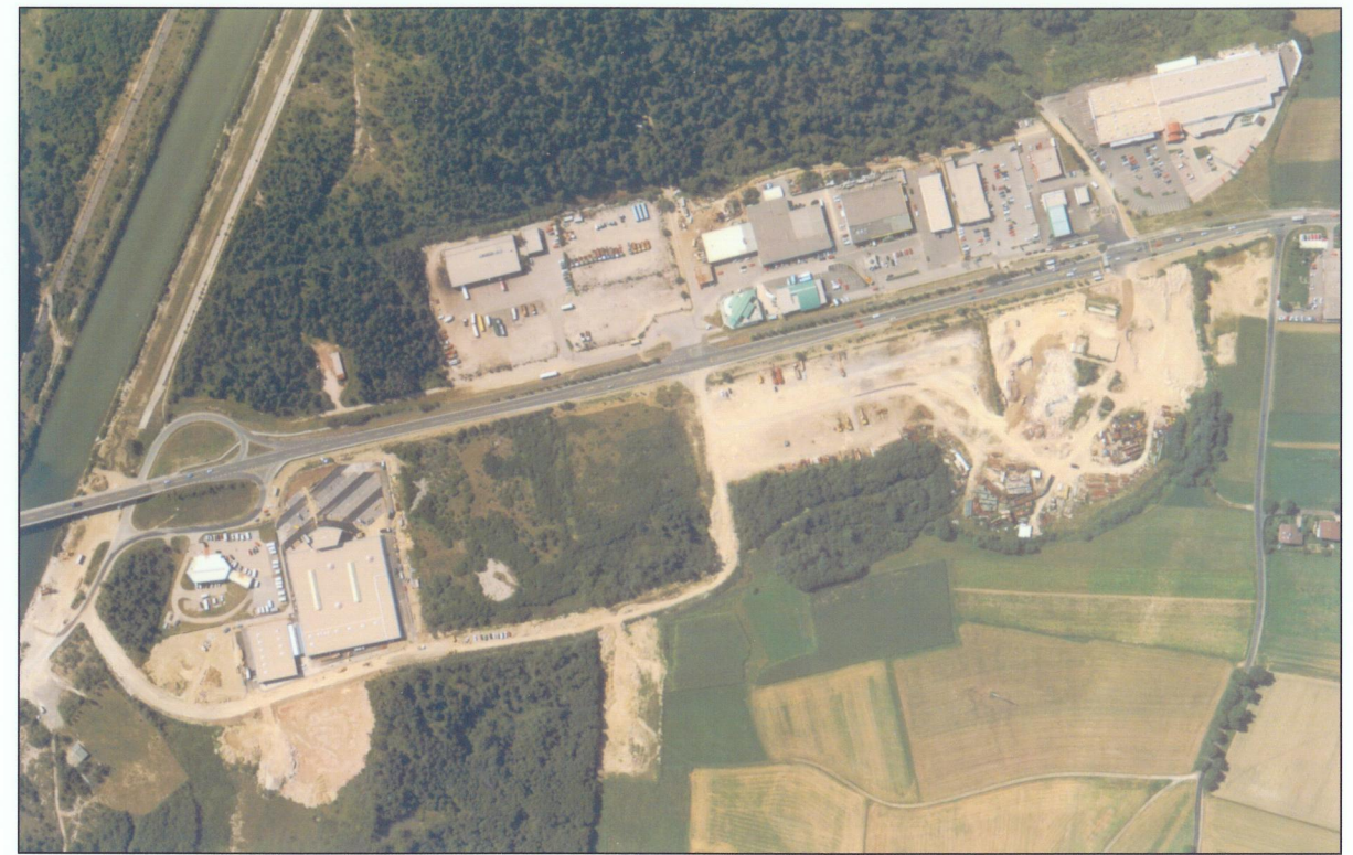
Gewerbegebiet Maria Gailer Straße, Bebauung im Jahr 1993
