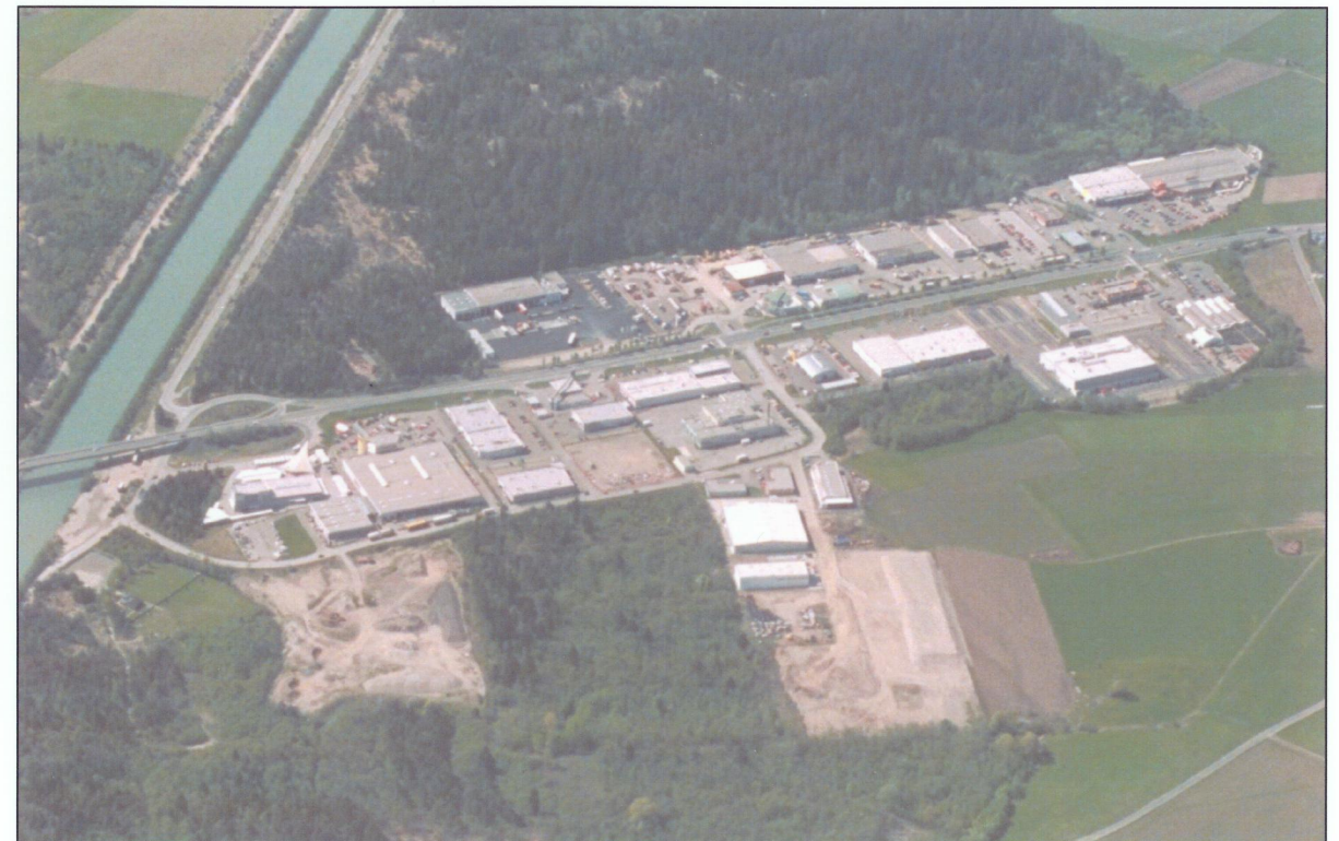
Gewerbegebiet Maria Gailer Straße, Bebauung im Jahr 1999
