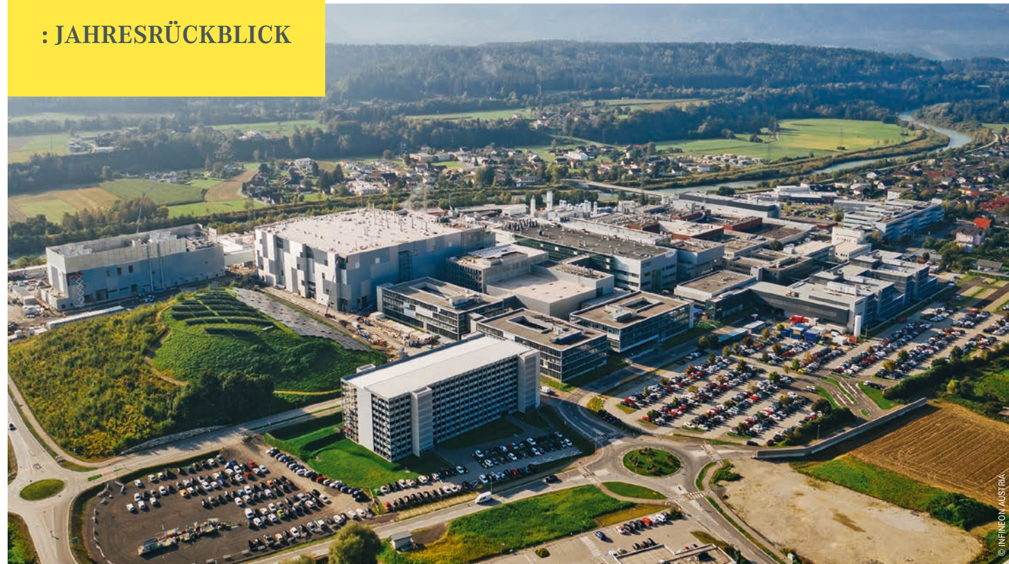
Die hochmoderne Infineon-Chipfabrik bringt Arbeit für hunderte zusätzliche Fachkräfte. Sie hat eine Bruttogeschoßfläche von 60.000 Quadratmetern, ist 120 Meter lang, 110 Meter breit und 35 Meter hoch (Am Bild Mitte links).
