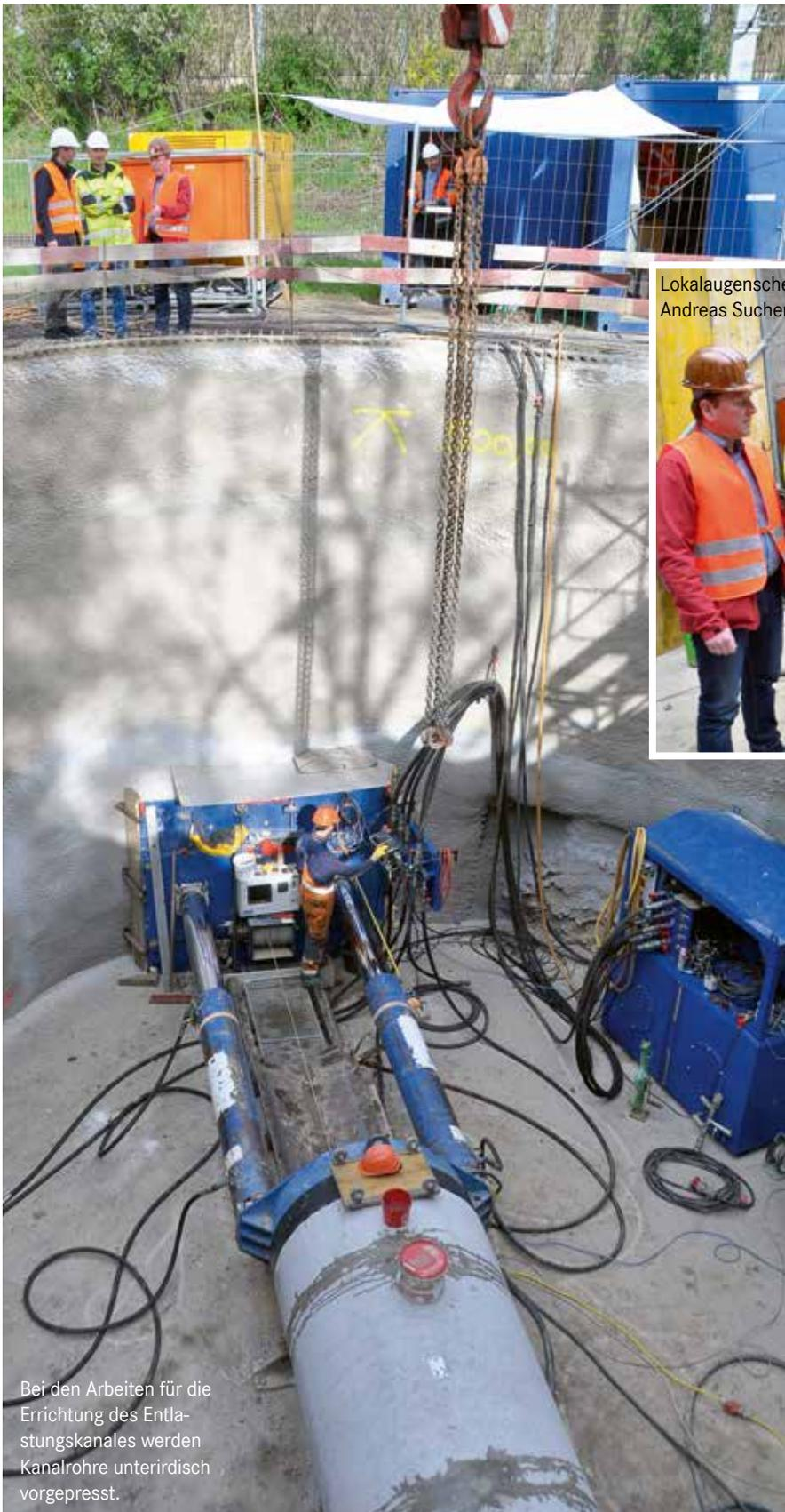
Bei den Arbeiten für die Errichtung des Entlastungskanales werden Kanalrohre unterirdisch vorgepresst.
