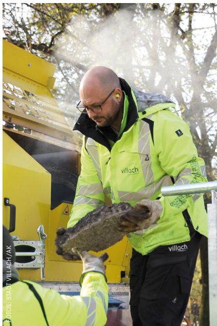
Aus alt mach neu! Asphalt-Brocken werden oben in die mobile Mischanlage gefüllt – und nach einer Hitzebehandlung kommt unten frisches Material für Sanierungen heraus.
