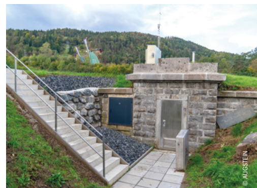
Die Möltschacher Quelle wurde in zwei Jahren rundum generalsaniert.
