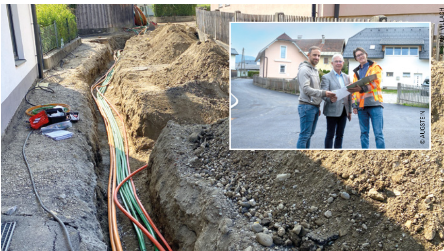
Im Möltschacher Weg wurde nach der Richtlinie neu gearbeitet. Von links: Bauleiter Martin Koller, Baureferent Stadtrat Harald Sobe und Werner Granitzer (Abt. Tiefbau).
