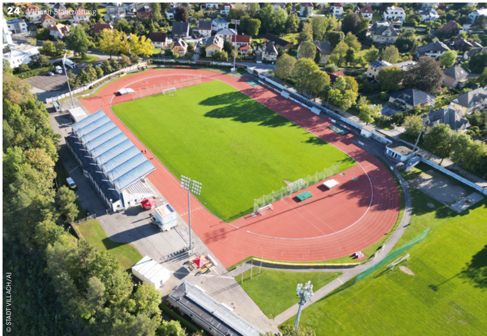
Die Leichtathletikanlage des Stadions in Lind, eine der beliebtesten Sportstätten Villachs, wird bis voraussichtlich Mitte Oktober umfangreich erneuert.
