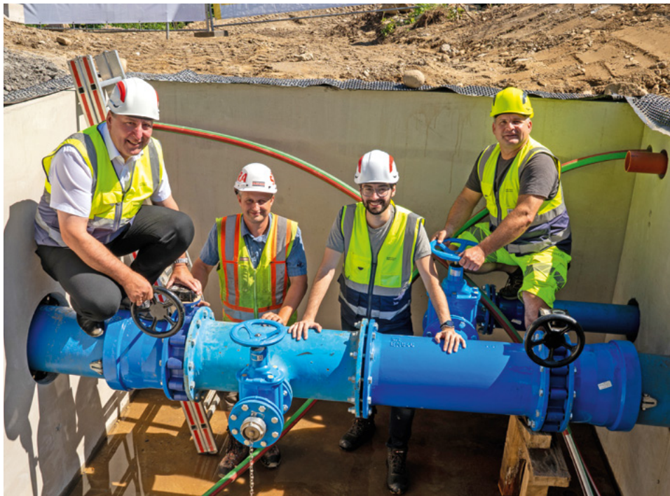
Men at work: Das Team des Wasserwerks hat die Vorarbeiten für die ASFINAG Großbaustelle Unterflurtrasse St. Andrä in kürzester Zeit erledigt.
