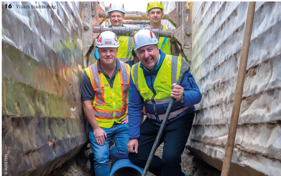
Intakte Leitungen sind die Grundlage für die Trinkwasserversorgung. Wasserreferent Stadtrat Erwin Baumann auf einer Baustelle in der Oberen Fellach.
