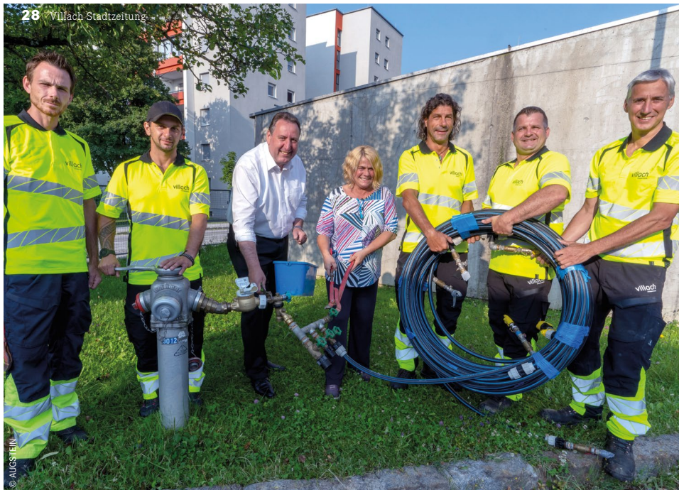
2000 Laufmeter lange Leitungen für den Kirchtag. Das Wasserwerk-Team und Referent Erwin Baumann arbeiten mit Kirchtagsobfrau Gerda Sandriesser Hand in Hand.
