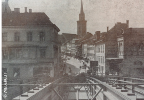
Die neue Stadtbrücke ist das größte Bauvorhaben der Stadt.
