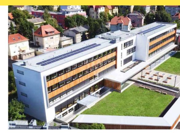
→ Volksschule Landskron: Dämmung, Installation von Luftungsgeräten mit Wärmerückgewinnung, Anbringung von Verschattungssystemen. Optimierung der heizungs- und raumlufttechnischen Anlagen sowie der Beleuchtung. Installation einer PV-Anlage, Anschluss an die Fernwärme.
