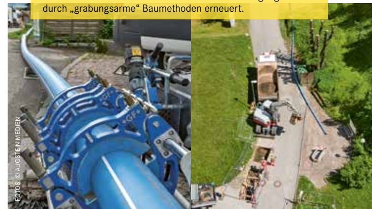
Im Villacher Stadtteil Gritschach wurde das Versorgungsnetz durch „grabungsarme“ Baumethoden erneuert.
