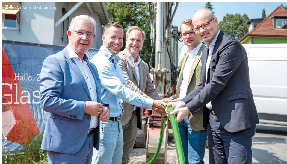
Gemeinsame Grabungsarbeiten (von links): Villachs Baureferent Stadtrat Harald Sobe, Alexander Stock (CTO A1), Christian Mehlführer (Director Fiber Factory, A1), Bernhard Deixler (CTO Alpen Glasfaser GmbH), Volker Libovsky (CTIO Magenta Telekom)
