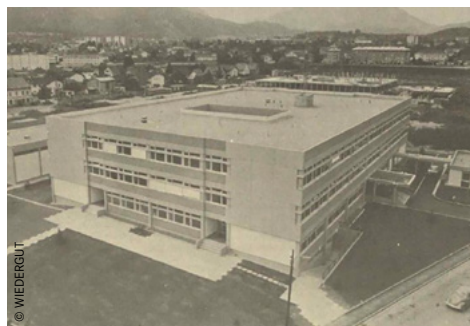
In knapp zwei Jahren Bauzeit wurde die neue Hauptschule in den Auen errichtet.
