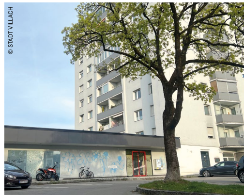
In der Kanaltalersiedlung wird eine Kita in der ehemaligen Billa-Filiale realisiert.
