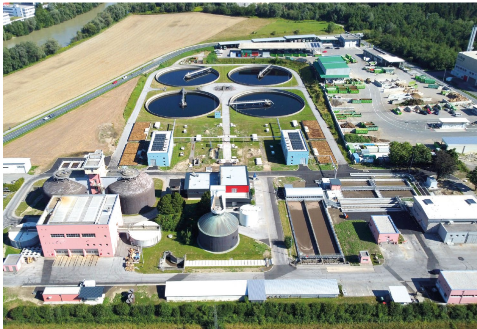
In der Kläranlage in St. Agathen werden jährlich rund 14 Millionen Kubikmeter Abwässer gereinigt. Heuer werden dort die PV-Anlage und das Betriebsgebäude erweitert.
