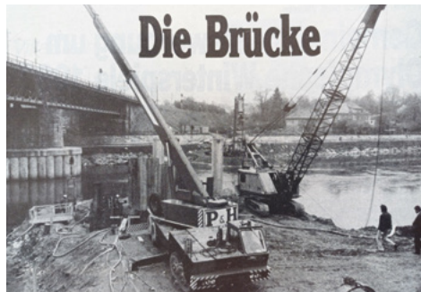
Der Bau der dritten Draubücke wird zu einem Wettlauf gegen die Zeit.
