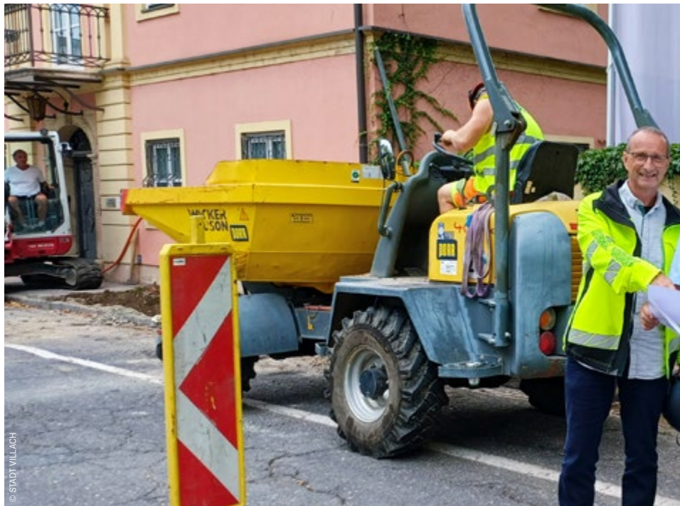
Stadtrat Harald Sobe mit Gerhard Duschmig, Leiter der Abteilung Tiefbau, und Martin Baumann (Tiefbau) bei der Baustelle in der Italiener Straße.
